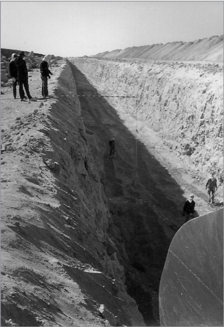
Un ancien chantier d'irrigation
